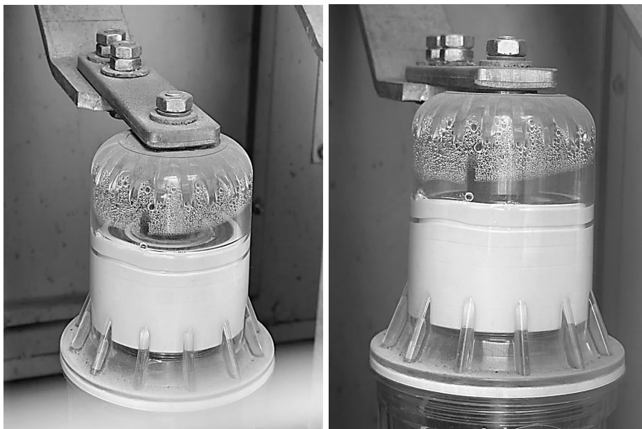
Рис. 2. Выпадение конденсата внутри корпуса фазы вакуумного выключателя типа ВВ/TEL-10-20/630 находящегося под напряжением на действующей подстанции в РУ-6 кВ (из архива авторов)
